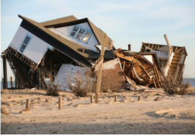
Gambar 1 Rumah dengan pondasi yang tidak kuat mengakibatkan rumah miring dan dapat roboh.
