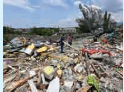
Kerusakan akibat gempa Sumber: liputan6.com
